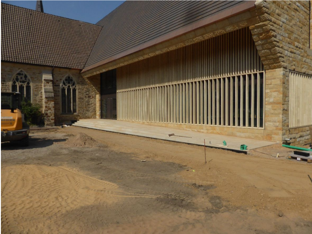
Der Neubau der Bibliothek im Rohbau vor Fertigstellung der Gartenanlagen
