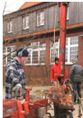
Probepbohrungen für die MZ-Erweiterung
