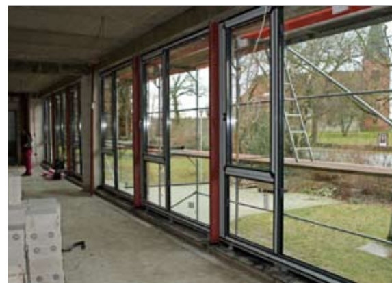
Die Hausgemeinde genießt die ersten Sonnenstrahlen. Der Aufzug für Lebensmittel wird eingebaut. Blick vom neuen Speisesaal auf die Kirche.
