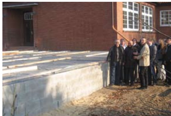
12. November 2011: Der FMD e.V. begutachtet den fertiggestellten Sockel des neuen Speisesaales.
