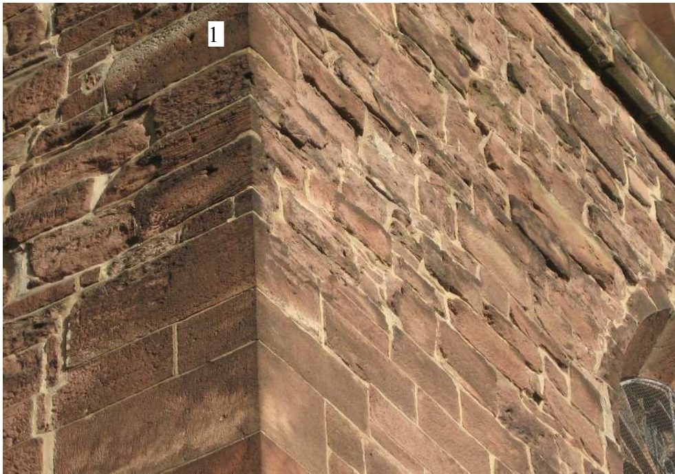
Abb. 68 Südquerhaus, Übergang zur Gotik mit Zangenlocheckquadern (1)
