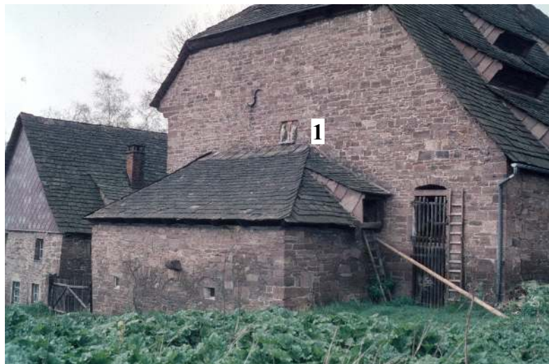
Abb. 178 Brauhaus und Stein vor dem Umbau 1965, Kühl
