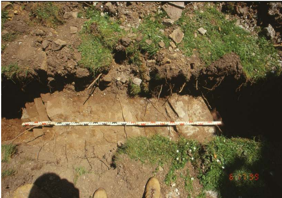
Abb. 70 Südflügel, Fundament des Refektoriums
