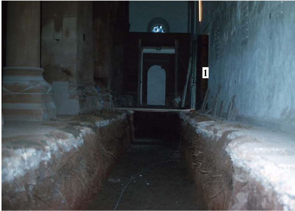
Abb. 185 Ausgehobener Luftkanal, rechts der Haupteingang (1), Nachlass Kühl
