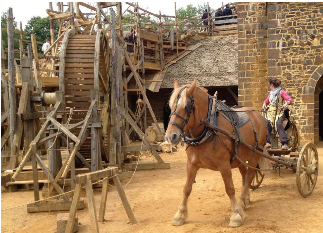
Abb. 41 Baustelle Guedelon ,Wikipedia Benoit Prieur 2014
