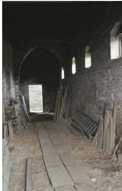
Abb. 190 Kreuzgang mit Blick auf den neuen Kirchenzugang, Nachlass Kühl
