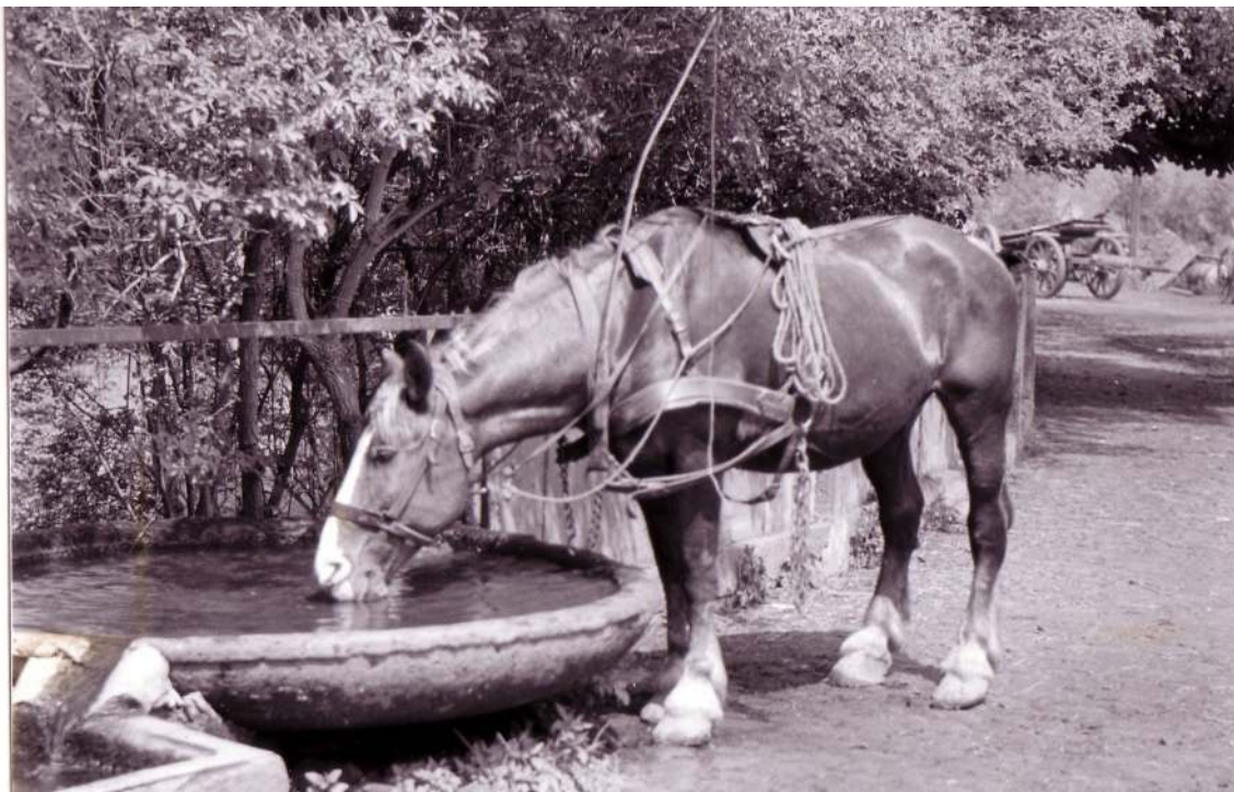
Abb. 145 Taufschale als Pferdetränke am Inneren Torhaus 1951, Hallensleben
