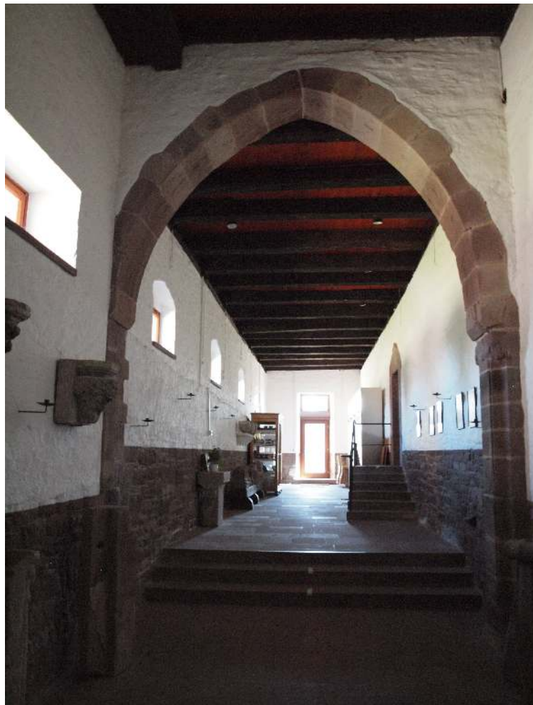
Abb. 50 Gotischer Schildbogen, Kreuzgangwestflügel
