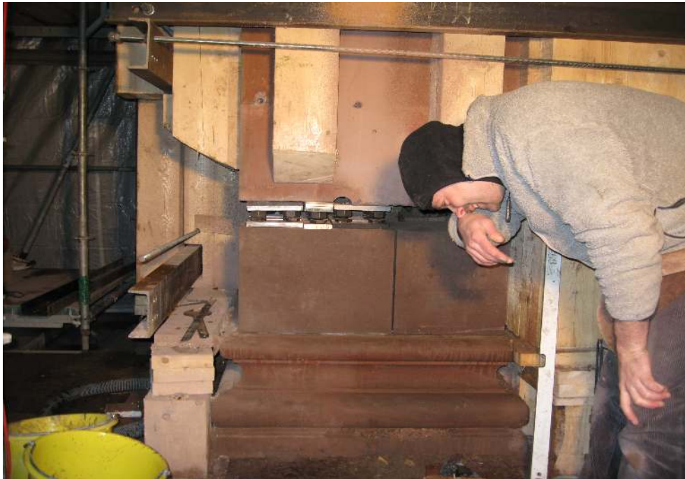
Abb. 196 Quaderaustausch am N/Ö -Vierungspfeiler
