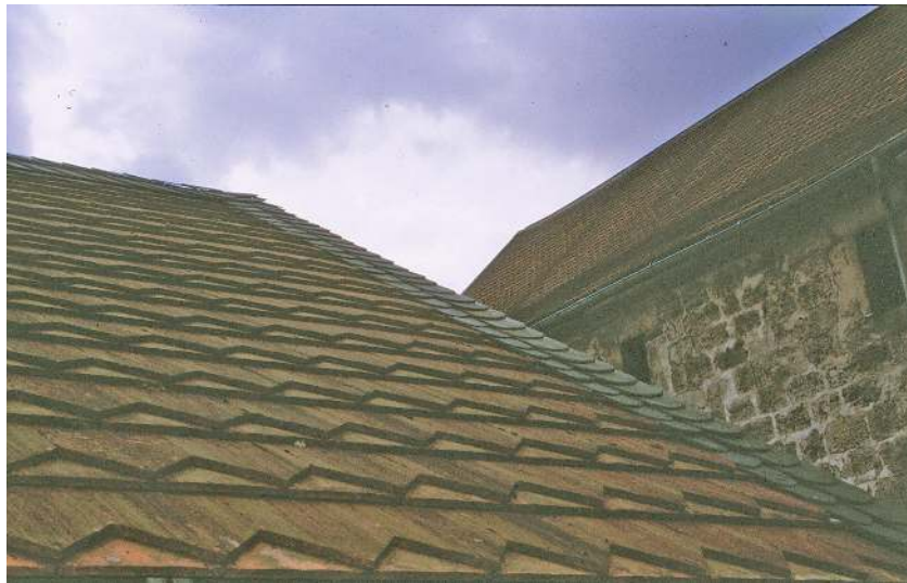
Abb. 96 Biberdachziegeldach in Walkenried
