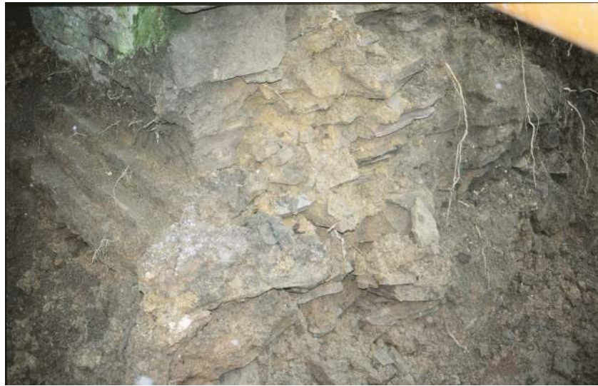
Abb. 76 Eiskellervorderfront, abgetreptes Fundament läuft durch
