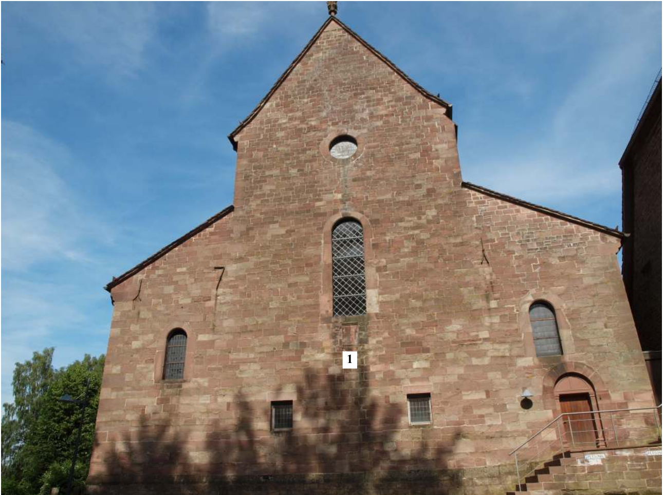
Abb. 116 Westseite, 1710 neu aufgemauert
