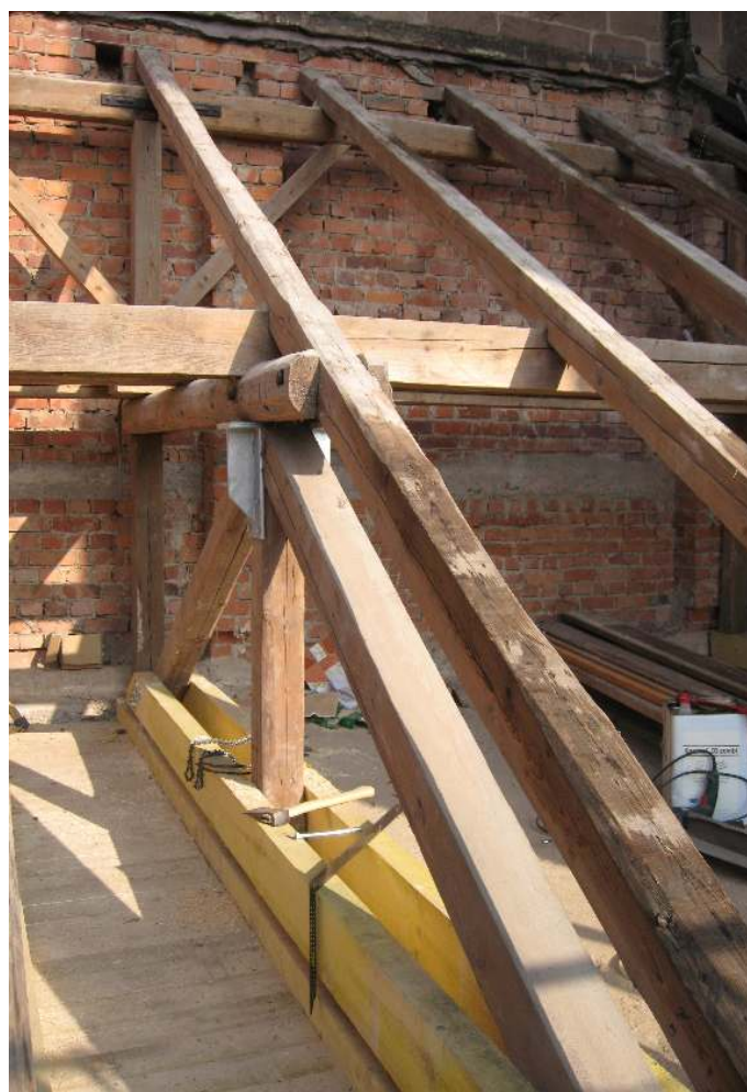
Abb. 207 Dachstuhl von Abb. 199
