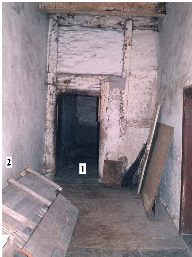
Abb. 181 Flur des „Stein“ 1965, Nachlass Kühl
