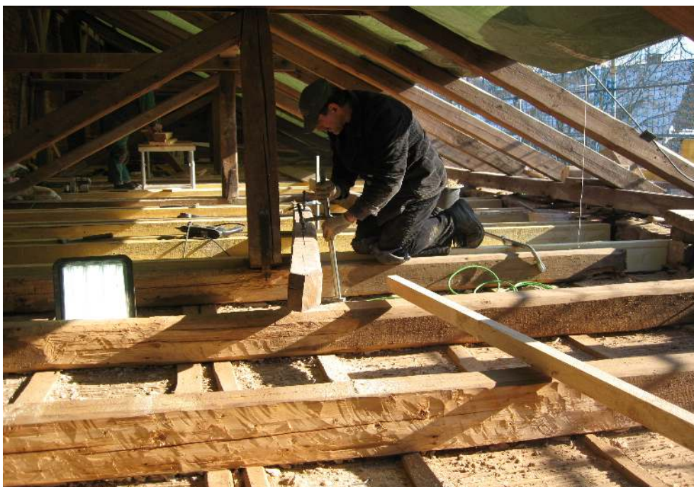
Abb. 206 Dachstuhl Sanierung südliches Langhausseitenschiff
