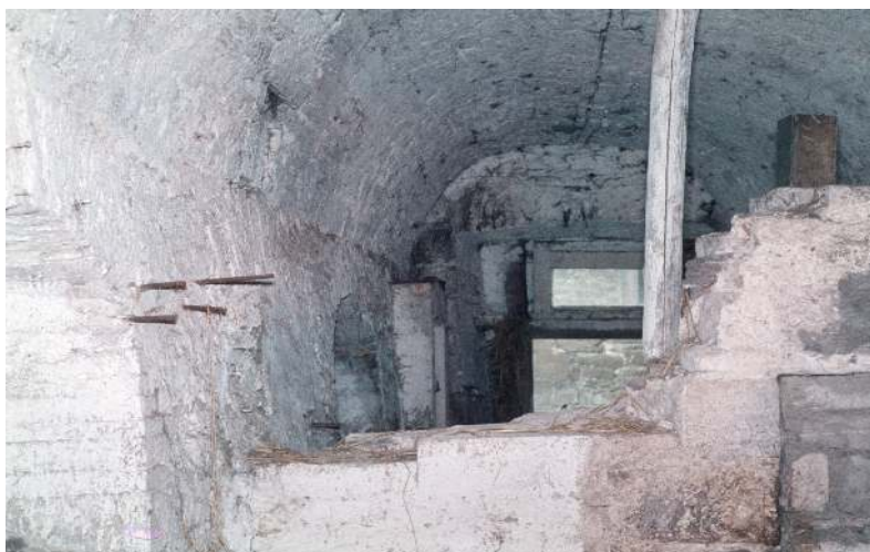
Abb. 180 Tonnengewölbe vor dem Garagenumbau 1965, Kühl
