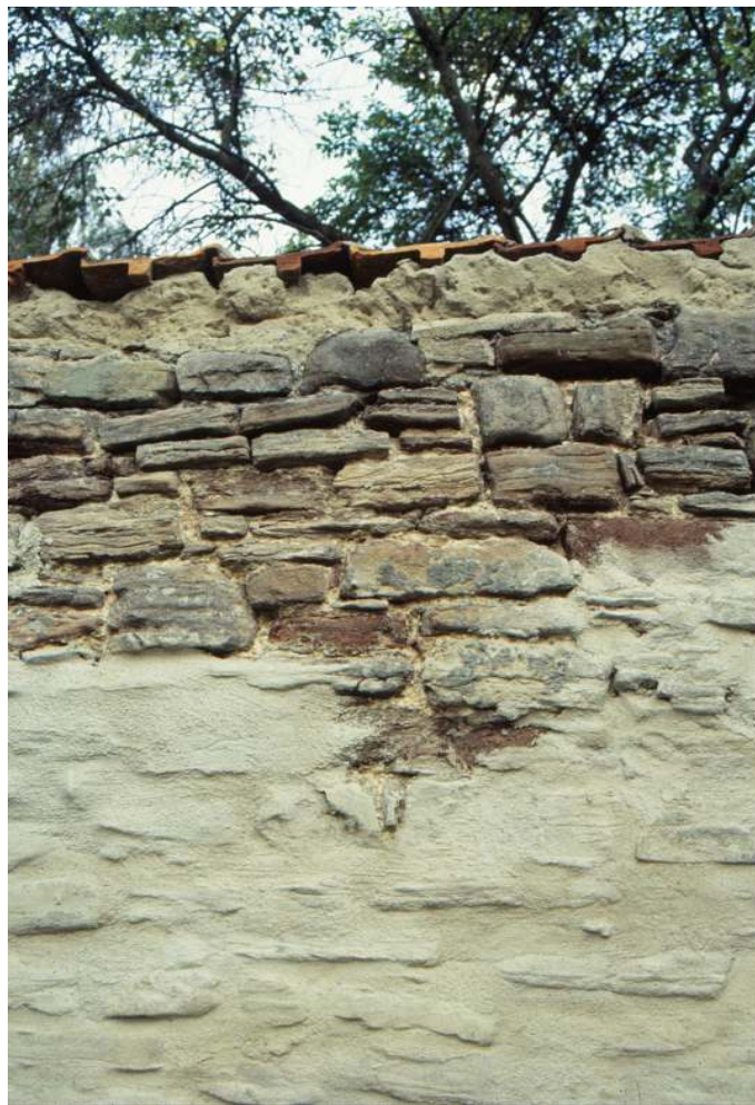
Abb. 62 Klostermauer in Drübeck mit neuer Kalkputzschlämme
