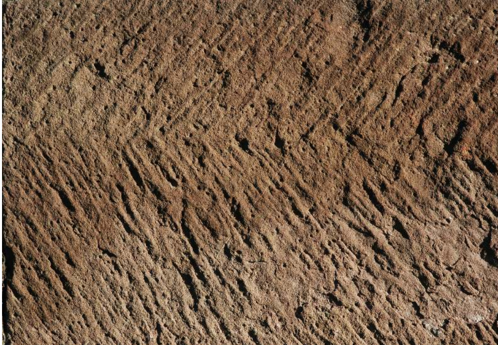
Quadermauerwerk, fischgradartig mit der "Fläche" geglättet, Abb. 25
