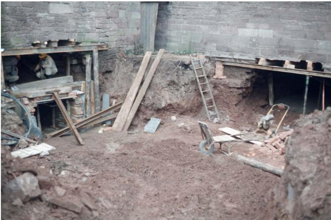
Abb. 58 Durchbruch des Heizungskanals zur Kirche
