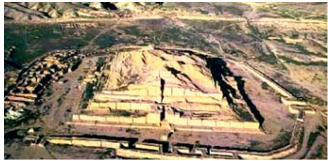
Turm zu Babel - das Fundament
