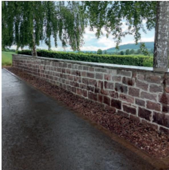
einem haltbaren Mörtel. Über Jahrzehnte drangen Pflanzen und Feuchtigkeit in die Fugen, Wurzeln lockerten die Struktur und Frost sprengte kleinere Risse auf. Die Mauer war nicht einsturzgefährdet – aber stark sanierungsbedürftig. Der Zustand machte eine umfassende Erneuerung unumgänglich.
