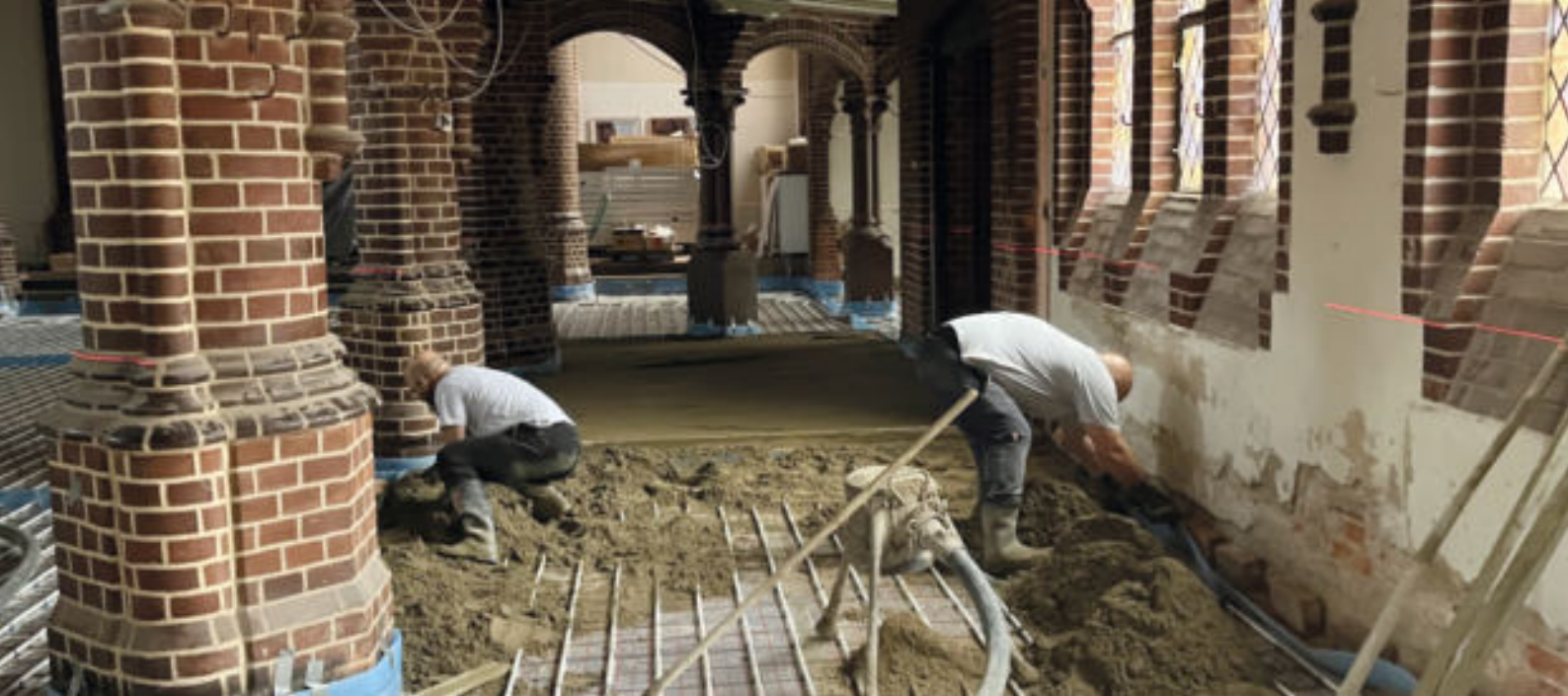
Viel Handarbeit ist für die neue Fußbodenheizung nötig. Foto: Michael Eberstein
