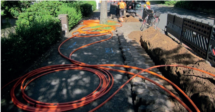
Bauarbeiten am Glasfasernetz in der Moorstraße
