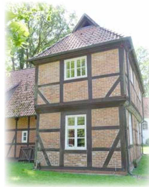
Abb. 3: Später hinzugefügter Querriegel am Pfarrwitwenhaus
