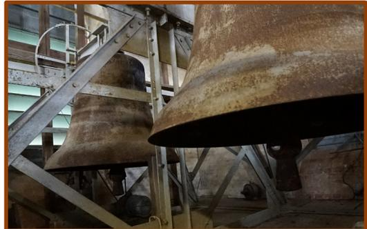
Eindeutig zu erkennen ist die oxidierte, rostige Oberfläche. Auf den Klöppeln sitzen Bronzebacken, die regelmäßig rundförmig nachgeschliffen werden müssen, sonst klingen die Glocken schepperig.
