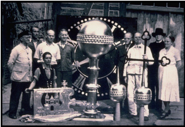
Die restaurierten Zier-, Schmuck- und Sinn-elemente des Kirchturms im Jahre 1950 (rechts: mit Hut Superintendent Apel mit seiner Ehefrau, vor ihm Malermeister Böhne und Dachdeckermeister Mairose; links: Handwerkergruppe)
