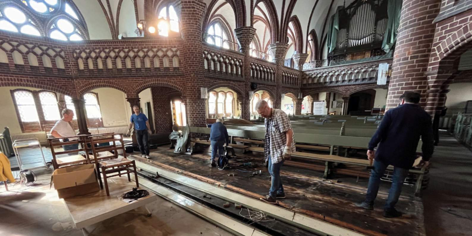
Mit gut einem Dutzend Helfern wurden im Mai die Bänke aus der Gospelkirche ausgebaut. Foto: Michael Eberstein
