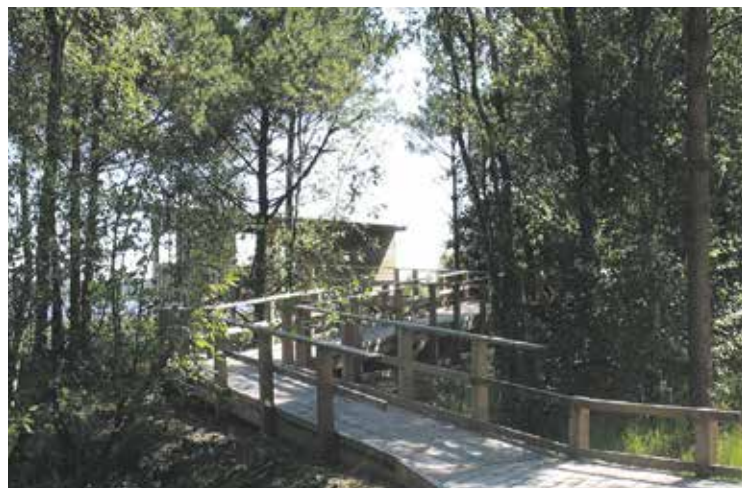
Mobilitätseingeschränkte Gäste können den neuen Turm barrierefrei über eine Rampe ab Endhaltepunkt Moorbahn erreichen.
