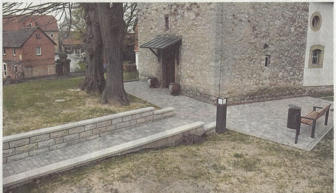
Frisch gepflastert, eine Mauereinfassung um den Weg, eine Bank und neue Lampen – so sieht es nun „hinter der Mauer“ aus. Die Rasenflächen werden demnächst noch mit Schotterrasen wiederhergestellt.
