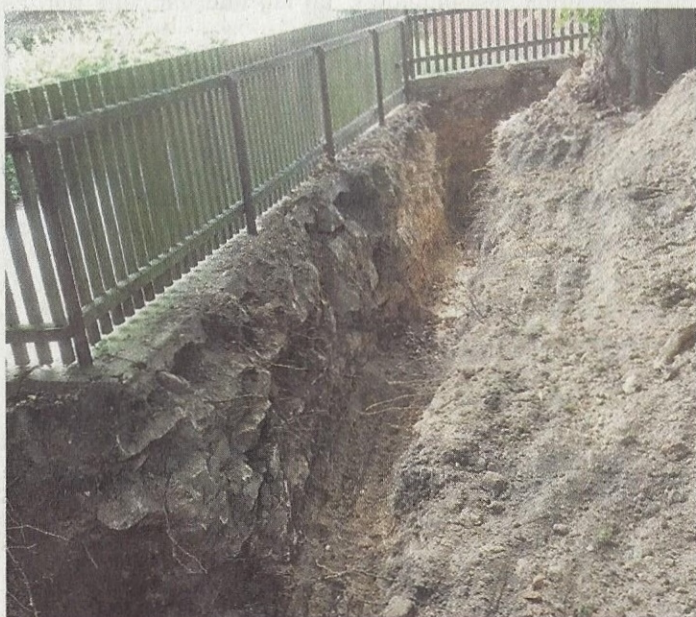
Die Steinmauer wurde neu verfugt und sie bekam eine Abschirmung gegen die Feuchtigkeit.
