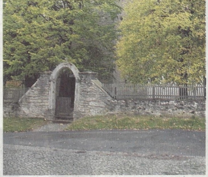
So sah es vorher aus: Mit Zaun auf der Mauer und einer zweistufigen Treppe am Eingang.
