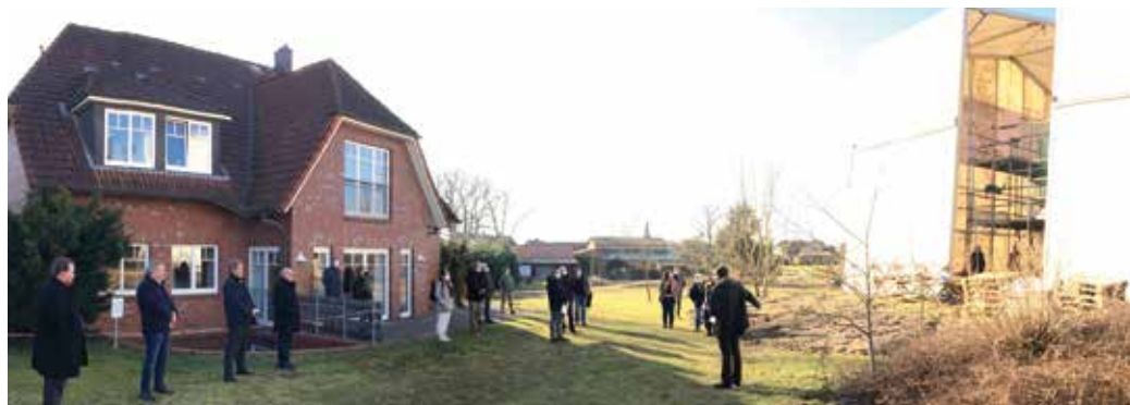
Foto: Richtfest des neuen Pfarrhauses mit Andacht und Grußworten hinter dem „Emmaushaus“ (rechts das geöffnete Zelt Dach)
