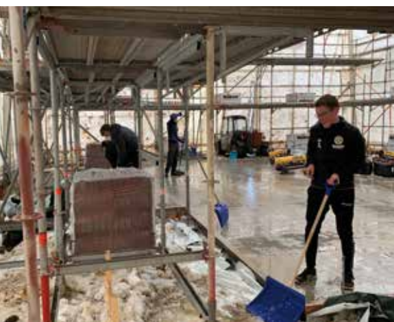
Fotos: Richtfest des neuen Pfarrhauses, Bau des Pfarrhauses im Zelt, Hausgemeinde beseitigt Schnee von der Bodenplatte, winterliches MZ (Seite 15)
